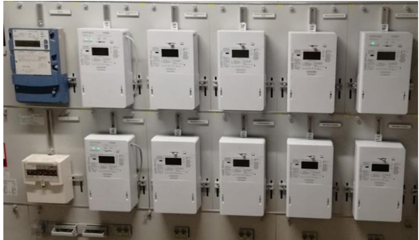
Mehrfamilienhaus: Verteilkasten mit Smart-Metern
